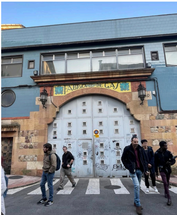
Fábrica de Gas y Electricidad de Oviedo de 1858. © Vanesa Martínez
